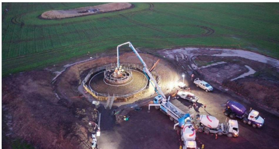
*Concrete Pour at the crack of Dawn
